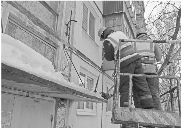
В Ульяновске продолжается очистка дворов и кровель многоквартирных домов от снега и наледи после обильных январских снегопадов. В первую очередь очищаются карнизы, расположенные над подъездами, тротуарами и другими местами прохода людей.
